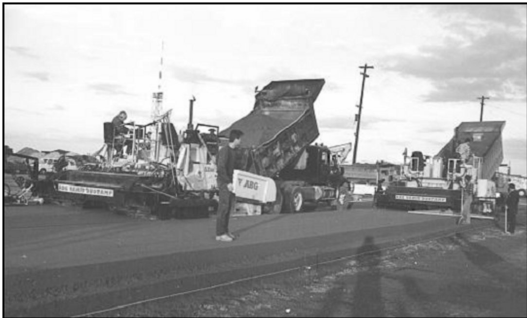
شکل ۱۵- بتن غلتکی در اف. تی.بنینگ
