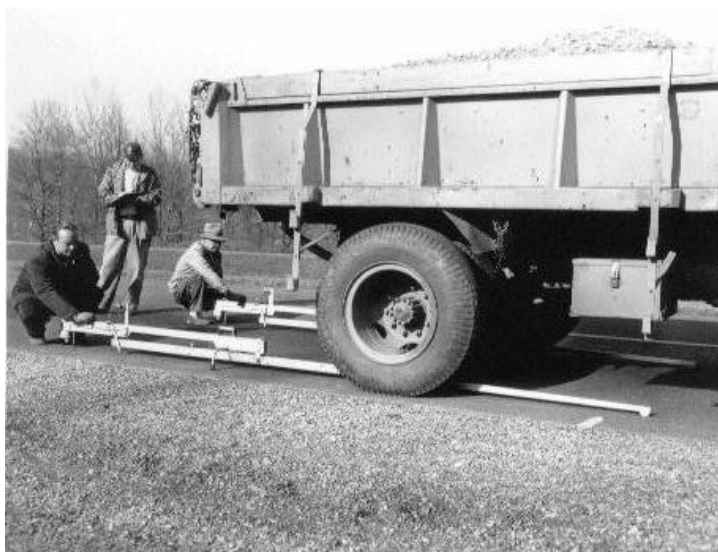
شکل ۲- تیر بنکلمن در آزمایش بزرگ آشتو
