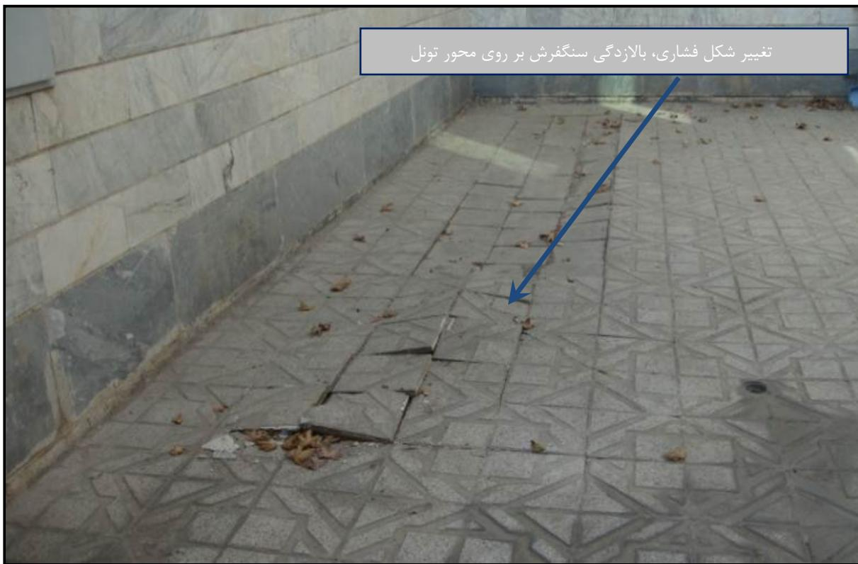
شکل پ.۱۰-۵- ایجاد بالازدگی سطح زمین در زون تحت فشار (بر روی محور تونل)
