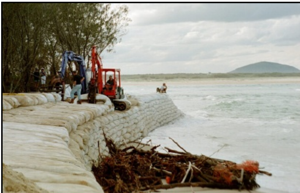
شکل ۳-۳۰- استفاده از ژئوسنتتیک به عنوان سازه نگهدارنده ساحلی در برابر نیروهای امواج
