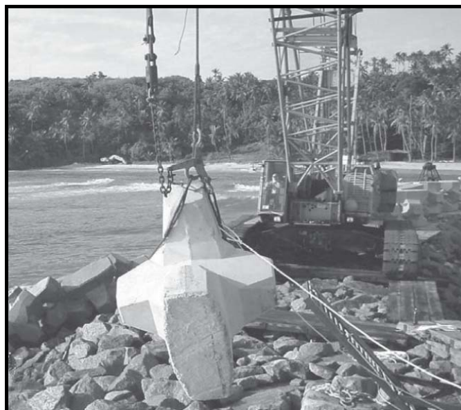
شکل ۵-۲۲- استفاده از قلاب بازشو برای استقرار آرمور
