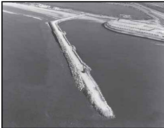
شکل ۵-۱۹- وجود پارکینگ در طول مغزه برای دور زدن و عبور وسایل نقلیه از کنار یکدیگر
