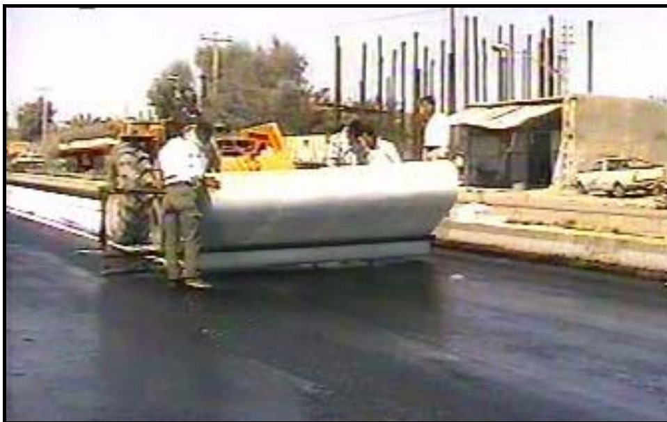
شکل ۳-۲۶- استفاده از ژئوسنتتیک برای روسازی راه
