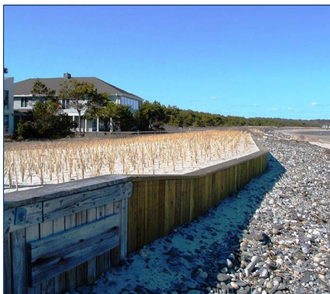
شکل ۳-۵- نمونه‌ای از یک نوع دیوار حایل ساخته شده توسط چوب (اسکاتلند)
