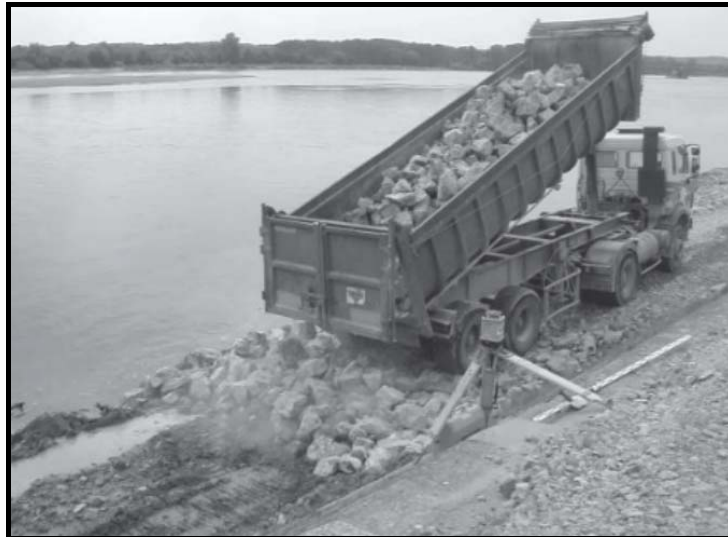
شکل ۷-۵- نمونه‌ای از کامیون‌ها که برای حمل و تخلیه مستقیم سنگ از معدن تا محل اجرا استفاده می‌شود.
