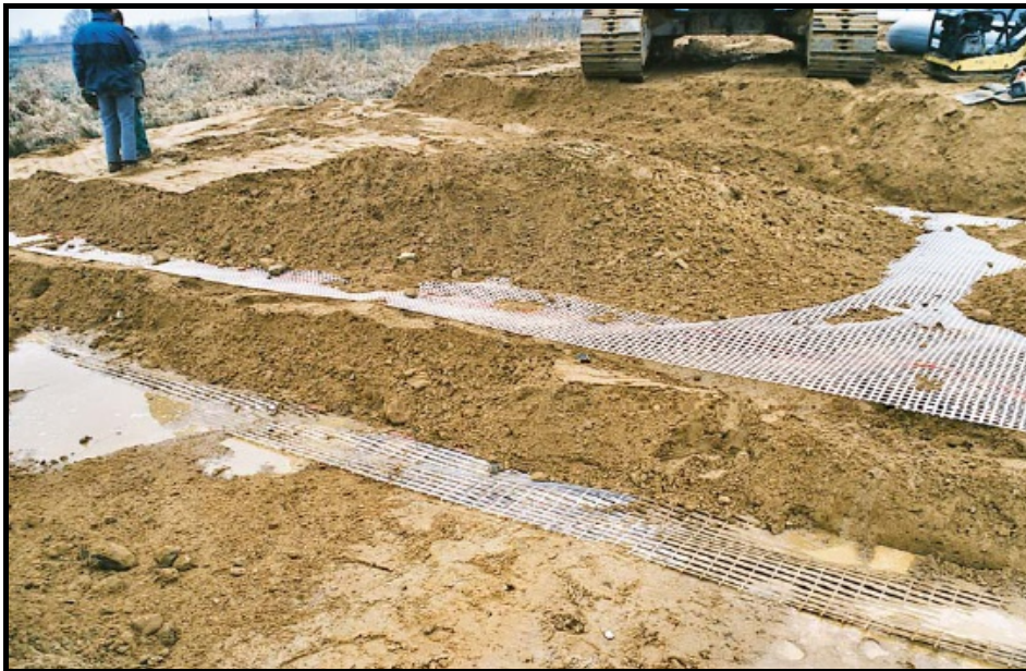
شکل ۳-۲۸- استفاده از ژئوگرید به عنوان تثبیت کننده بستر
