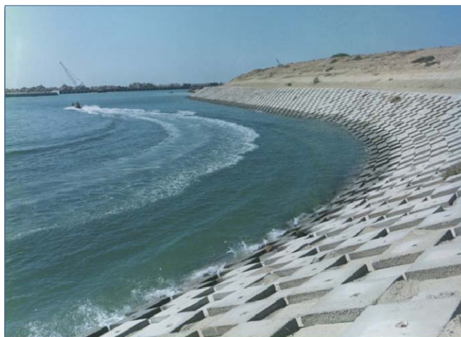
شکل ۳-۴- نمونه‌ای از یک پوشش محافظ ساخته شده توسط قطعات بتنی (بندر شهید کلاانتری، ایران)
