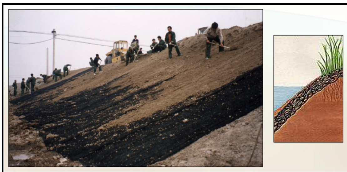
شکل ۳-۳۱- استفاده از ژئوسنتتیک برای جلوگیری از فرسایش سطحی خاک
