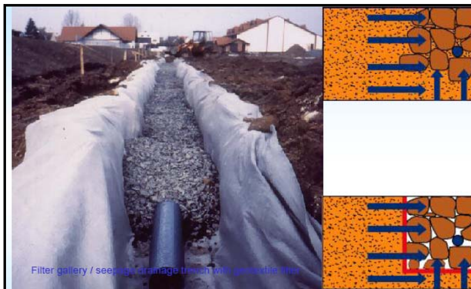
شکل ۳-۲۷- نقش ژئوسنتتیک به عنوان فیلتر
