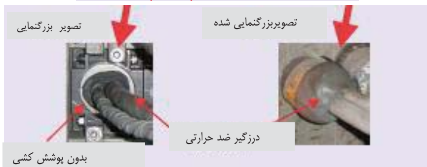
شکل ۲۲-۵ آب‌بندی اتصال مجرای انتقال کابل
