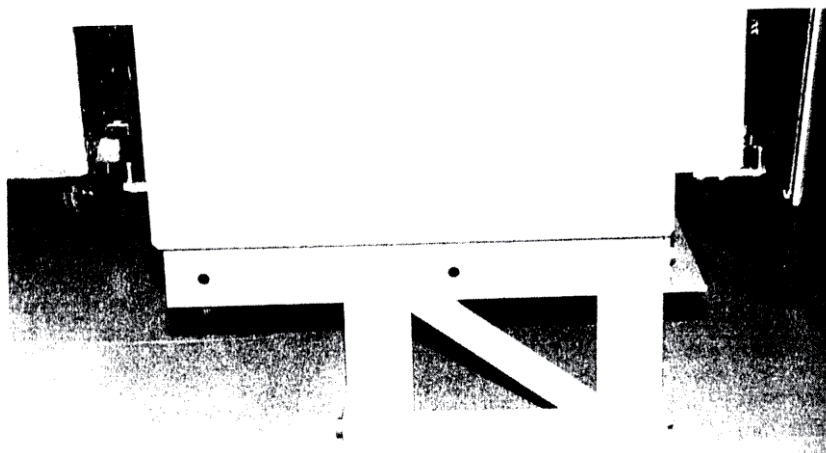
شکل ۵-۸- استفاده از بدستال سازه‌ای در کف کاذب
