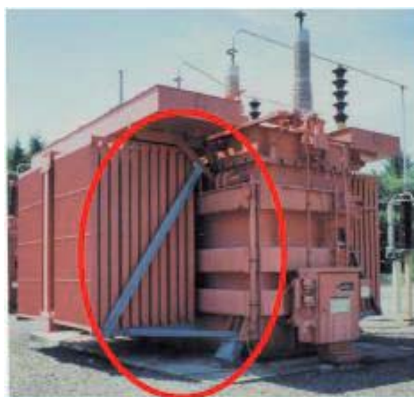
شکل ۵-۵ تقویت مهار بندی رادیاتور ترانس
