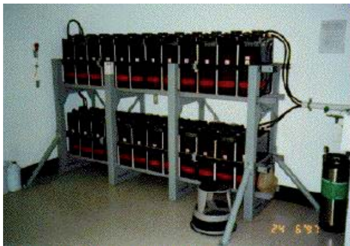
شکل ۵-۱۰ مهار بندی قفسه باتری‌ها جهت کنترل واژگونی
