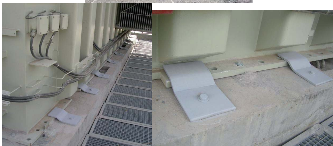
شکل ۵-۴ تعبیه ترمز در پایه ترانس برای کنترل مد لغزش
