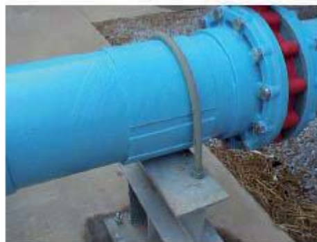
شکل ۵-۷ آرایش پیچ U شکل
