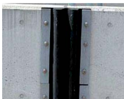
شکل ۶-۱۰ درز با مصالح انعطاف‌پذیر
