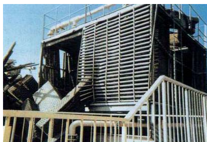
شکل ۹-۲ آسیب دیدگی برج خنک کننده. به علت وجود پرکننده‌ها (سازه‌ها) هیچ لغزشی مشاهده نشده است.
