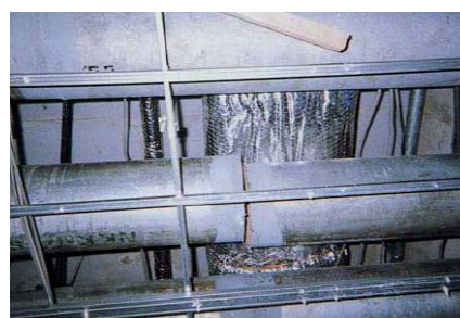
شکل ۹-۳ آسیب دیدگی لوله کشی خنک کننده آب. (در اثر نیروی لرزه‌ای جانبی قسمت جوش شده لوله دچار آسیب دیدگی شده است)
