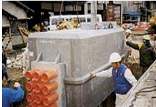
شکل ۷-۲ نمونه اقدامات ضد لرزه‌ای در آدم‌روی درجا و پیش‌ساخته
