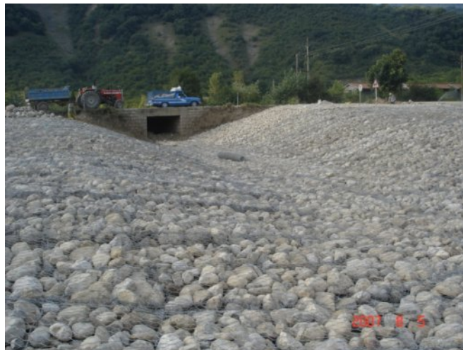
شکل ۵-۶- نمونه‌ای از تشک توری سنگی ساحل راست
