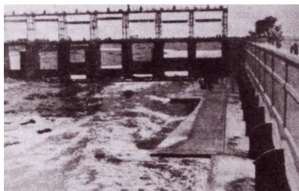
شکل ۵-۳۶- تونل‌های انحراف رسوب در کانال جامنای غربی در هندوستان [۳۷]
