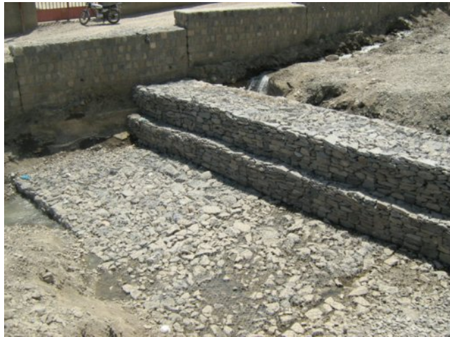
شکل ۵-۵- نمای کف‌بند توری سنگی کنار دیواره سنگی ساحل راست
