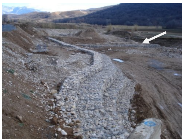
شکل ۵-۴- کفبند توری سنگی پایین دست حوضچه آرامش
