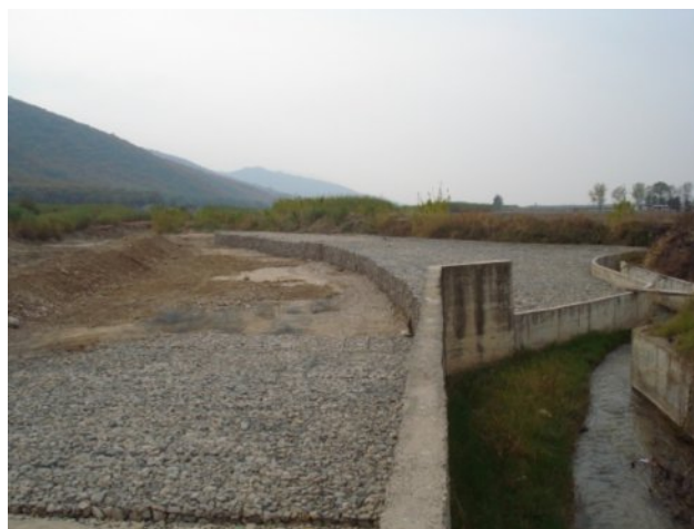
شکل ۵-۳- اجرای کفبند توری سنگی داخل رودخانه
