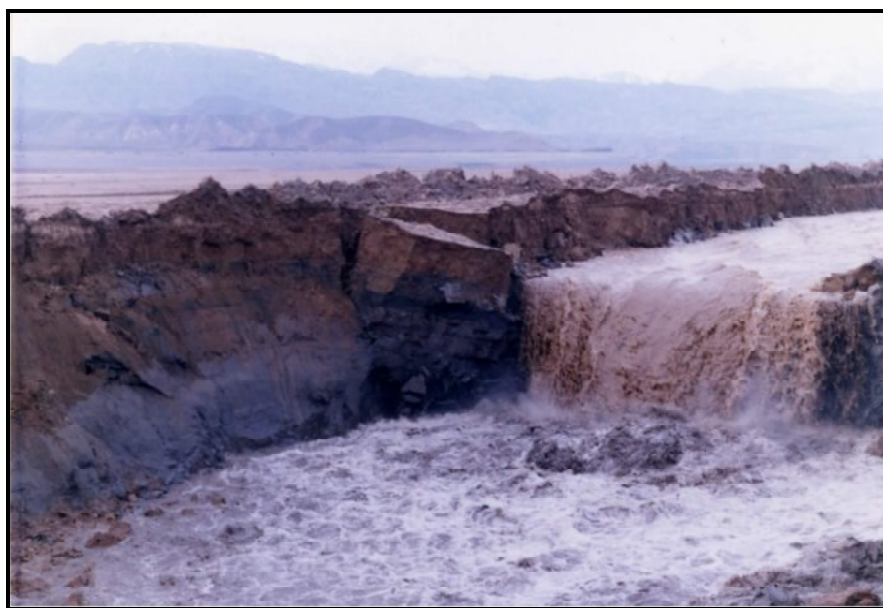
شکل ۶-۱۱- تصویری از فرسایش پس‌رونده در یکی از کانال‌های حفر شده در سد سفیدرود در حین عملیات رسوب‌زدایی [۳]
