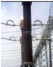
مواد سرامیکی به دلیل ویژگی‌های عایقی که دارند، تجهیزات ولتاژ بالا جهت جدا نمودن قسمت‌های برق دار مورد استفاده قرار می‌گیرند.
