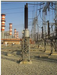
برای اندازه‌گیری ولتاژ درون خط بکار می‌رود و اطلاعات خروجی آن می‌تواند برای محافظت از سیستم، اندازه‌گیری‌های الکتریکی و کارهای کنترلی بکار رود. این دستگاه به صورت موازی در مدار قرار می‌گیرد.
