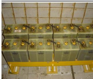
به مجموعه‌ای از سلول‌ها که در آنها فعل و انفعالات الکترو شیمیایی قابل رفت و برگشت صورت می‌گیرد، باتری می‌گویند. هر سلول متشکل از صفحات مثبت و منفی و ماده‌ای به نام الکترولیت تشکیل شده است.
