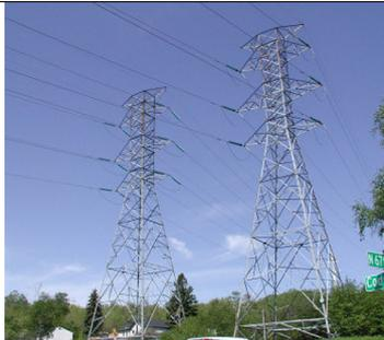
به سازه نگهدارنده کابل‌های فشار قوی و متوسط (بیشتر از ۶۳ کیلوولت) گفته می‌شود. این نوع دکل معمولاً فلزی و متشکل از قطعات نبشی با اتصالات پیچی می‌باشد. در صورت عبور سیم از دو طرف دکل به آن دکل دو مداره می‌گویند.
